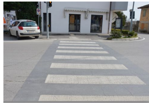
Vernice con microsferi rifrangenti e semaforizzazione
