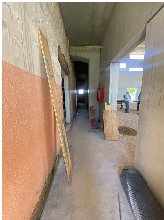
Corridoio di collegamento palestra-scuola
