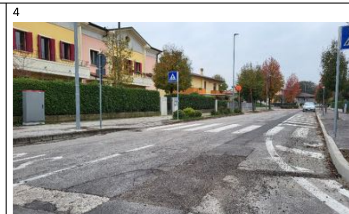
4 Passaggi pedonali poco accessibili
