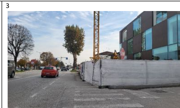
Via Garibaldi incrocio via IV Novembre (lavori in corso) / assenza percorso pedonale/ delimitazione e pavimentazione
